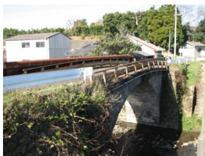
■保全されている山神橋(高尾野地区)
