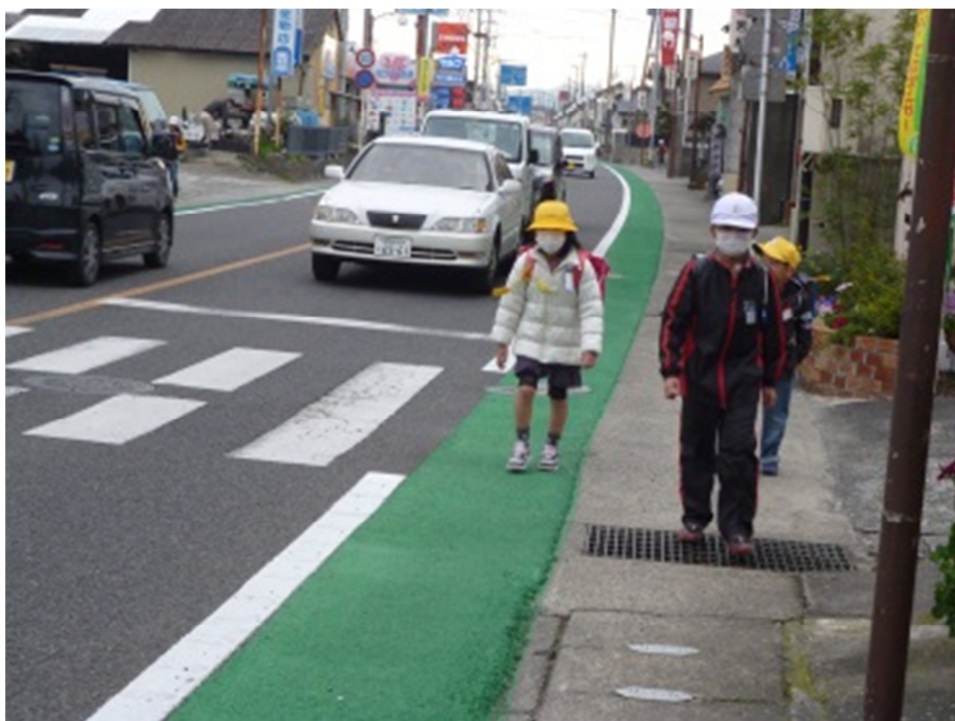
【高尾野小学校前を通る国道504号の「カラー塗装」】
