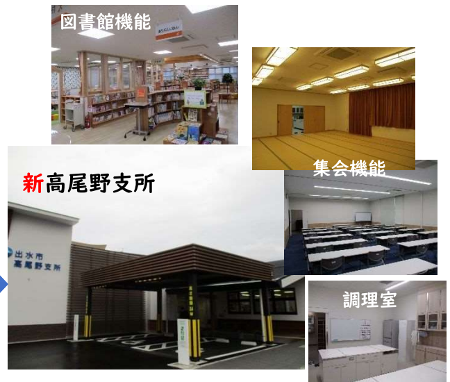
この写真は一部です。この他、支所機能・ロビー・小会議室・防災備蓄室等を備えます。
