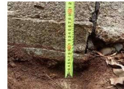
▲①沈下(h=170mm)
