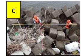
▲④移動・散乱(A-3 消波工)
