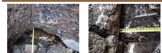
▲⑤洗掘(奥行90mm) ▲⑥移動(W=20mm)
