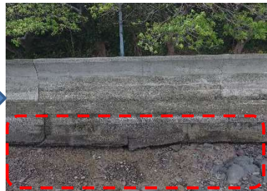
一定区間No.3の前面海底地盤及び根固工状況
