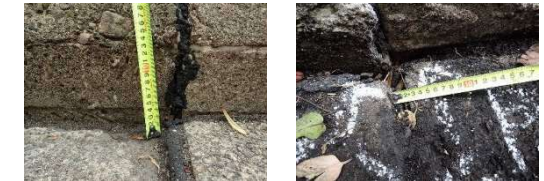
▲①沈下(h=140mm) ▲②開き(W=20mm)
