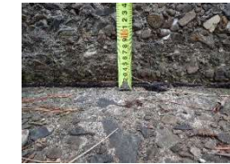
▲①沈下(h=70mm)
