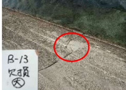
▲簡易的な損傷状況の確認
