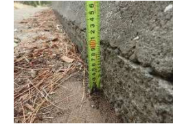
▲①沈下(h=100mm)
