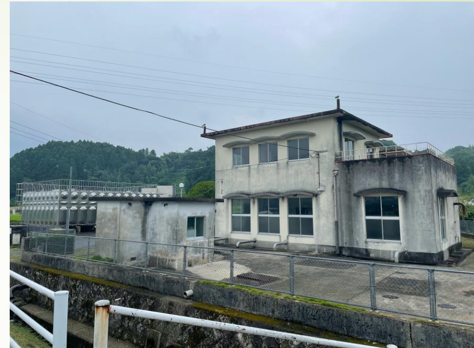
【小原ポンプ場…昭和35年度整備】
