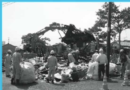
ボランティアに感謝 (一社)鹿児島県解体工事業協会
