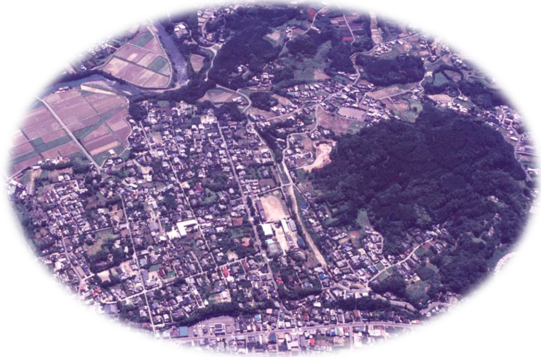
出水城（亀ヶ城）跡[右側の森林部分]と出水麓地区の武家屋敷群
