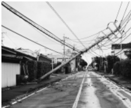
平成11年9月の台風18号による被害
