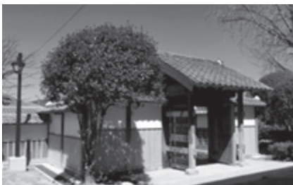
出水御飯屋門修理事業
