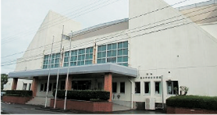
マルマエスポーツセンター出水 (市総合体育館)
