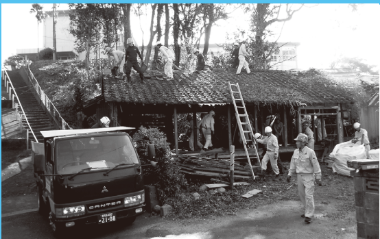
ボランティアに感謝 危険空き家の解体撤去
