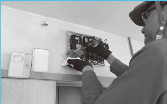
電気設備を無料点検 出水電気工事工業協同組合
