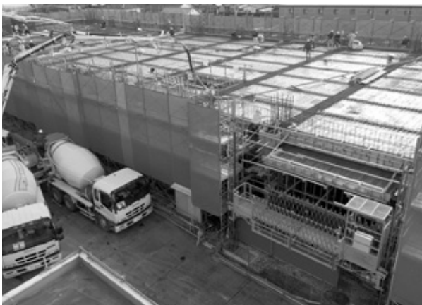
▷写真右下の機械がロングスパンエレベーター
