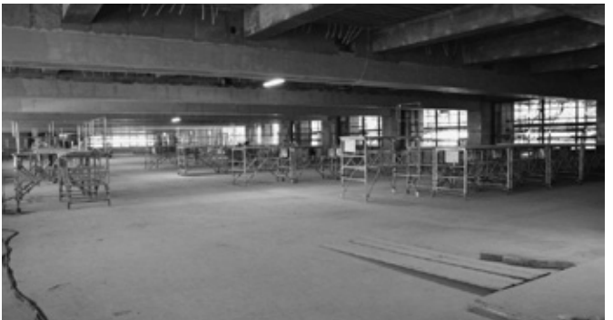
現在工事中の新庁舎内部2階(4月15日撮影)
