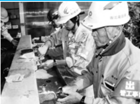
水道施設を点検・修繕 水道週間
