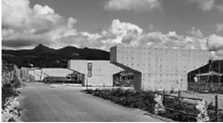
建設中の南九州西回り自動車道
