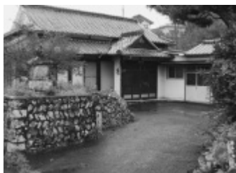
麓地区の空家
